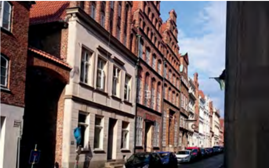
Die Plastizität Lübecker Fassaden: Bündig oder tief in den Fassaden sitzende Fenster und Türen sowie vorspringende Applikationen
