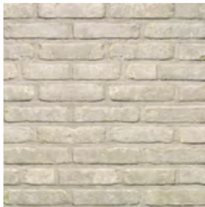
Detailabbildung von verschieden dick überschlämmten Ziegelmauerwerkswänden
