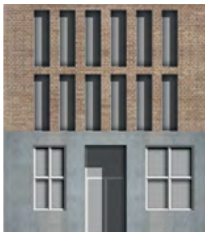
Erdgeschosszonen in Sichtbeton Links gestockt und aufgehellt, rechts glatt geschalt mit sichtbaren Schalungsstößen- und ankern
